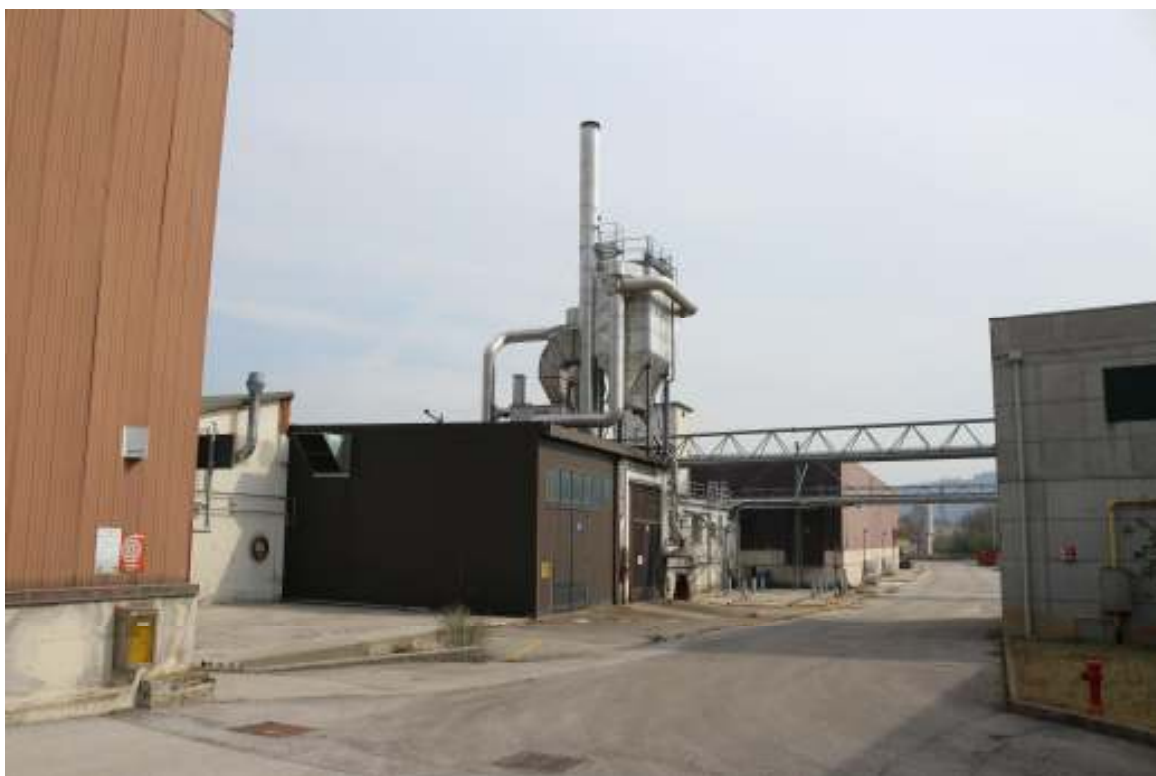
FOTO n°6. - visione esterna fabbricato – LOTTO 1.1
