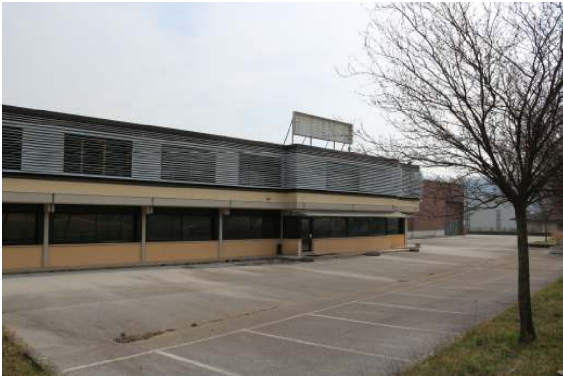
FOTO n°2. - visione esterna fabbricato - LOTTO 1.1
