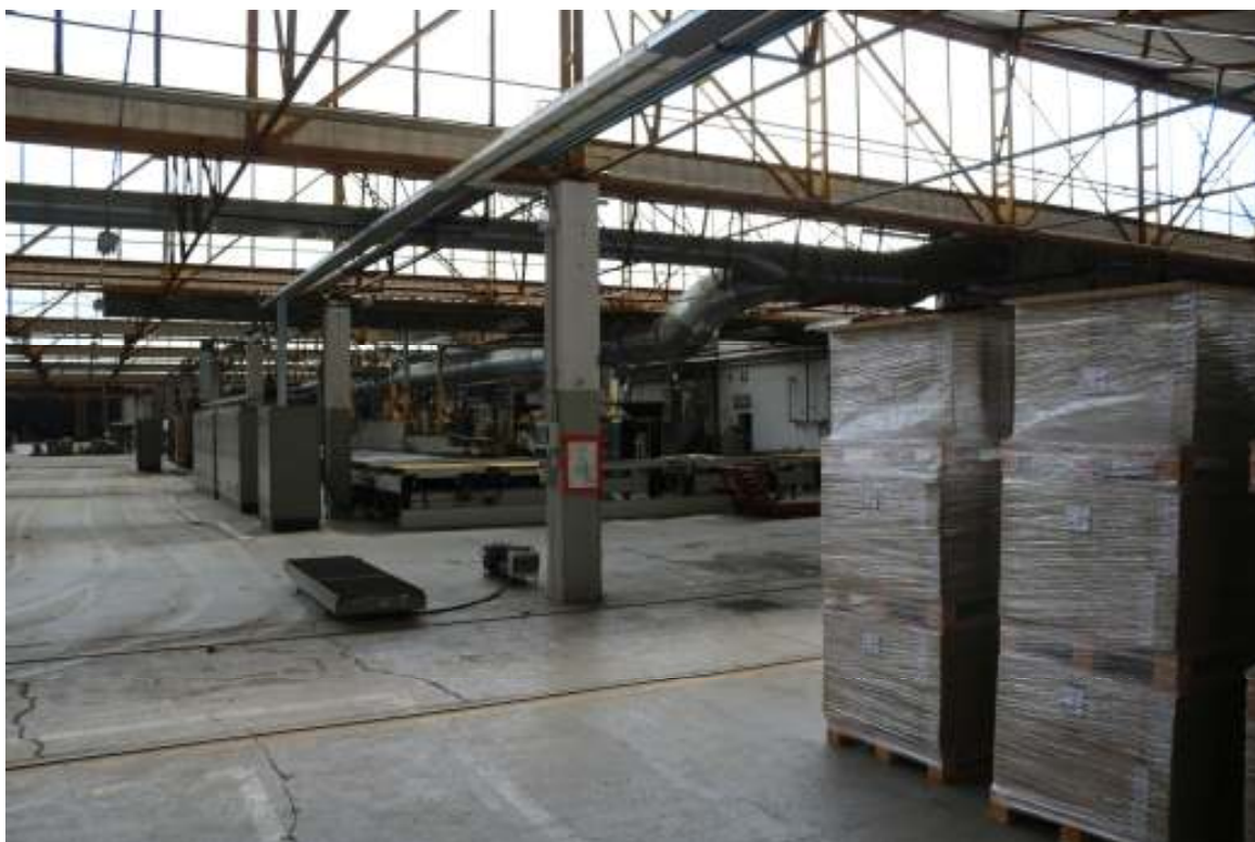
FOTO n°13. - visione interna fabbricato – area produzione – LOTTO 1.1
