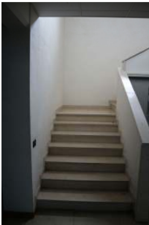
FOTO n°8. - visione interna fabbricato – area uffici – LOTTO 1.1
