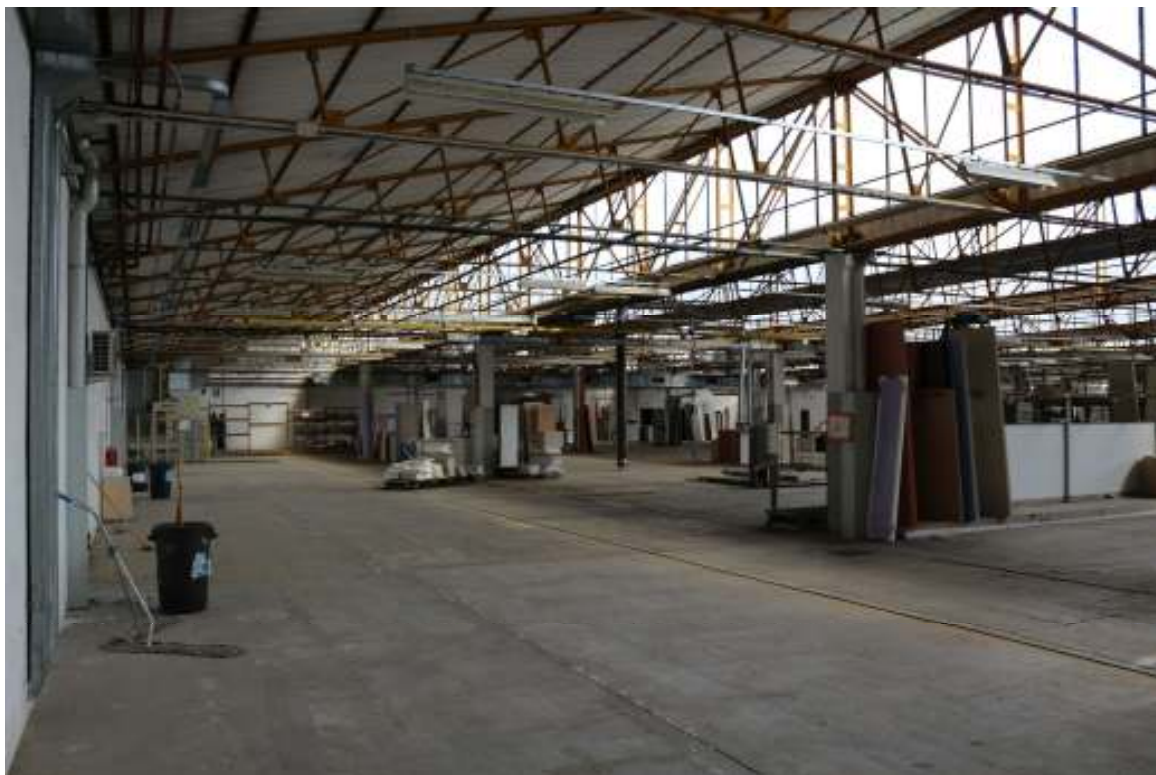
FOTO n°11. - visione interna fabbricato – area produzione – LOTTO 1.1
