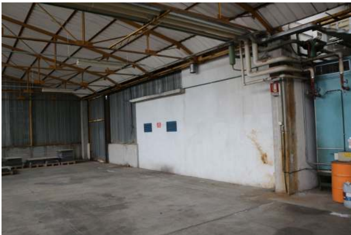
FOTO n°12. - visione interna fabbricato – area produzione – LOTTO 1.1
