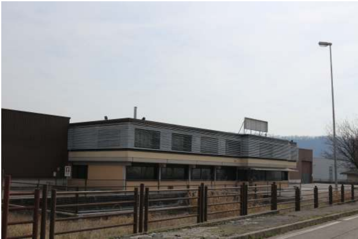
FOTO n°1. - visione esterna fabbricato - LOTTO 1.1
