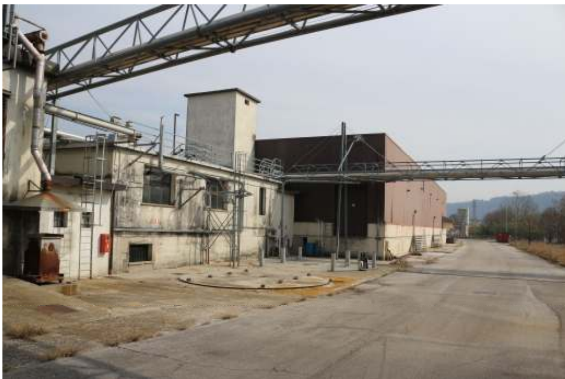
FOTO n°5. - visione esterna fabbricato – LOTTO 1.1
