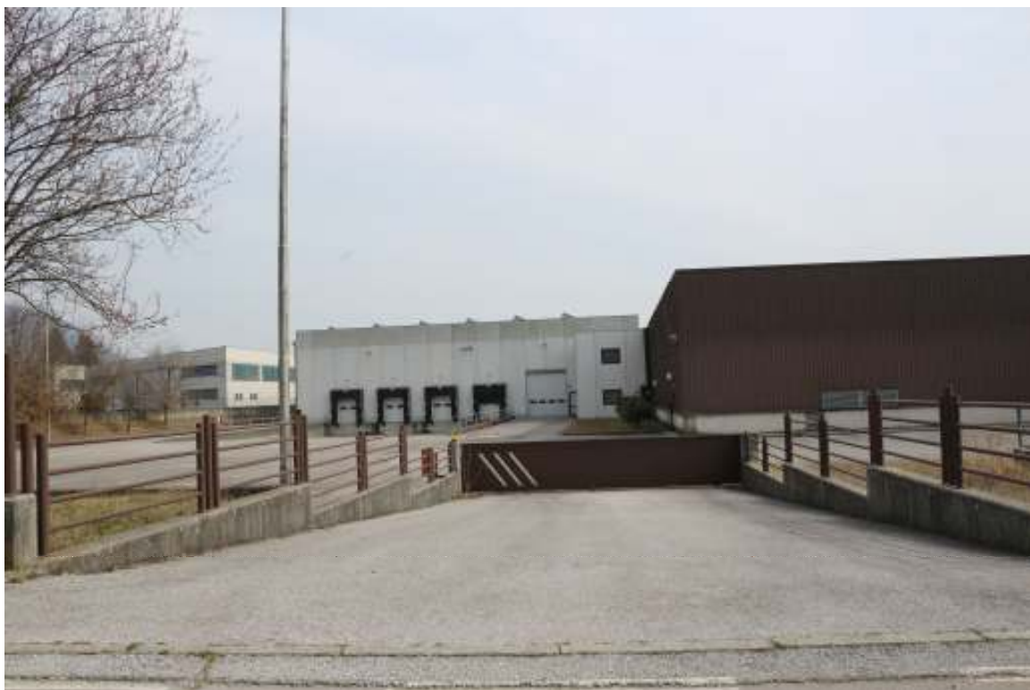
FOTO n°4. - visione esterna fabbricato - LOTTO 1.1
