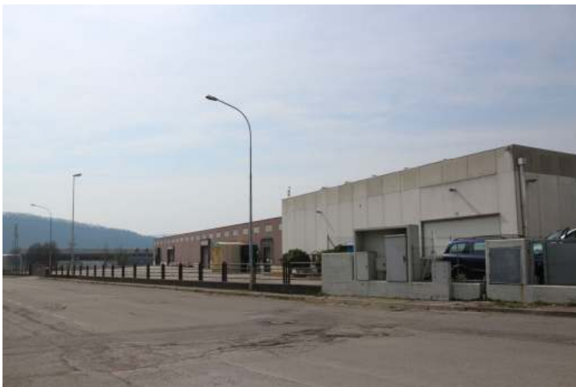
FOTO n°3. - visione esterna fabbricato - LOTTO 1.1
